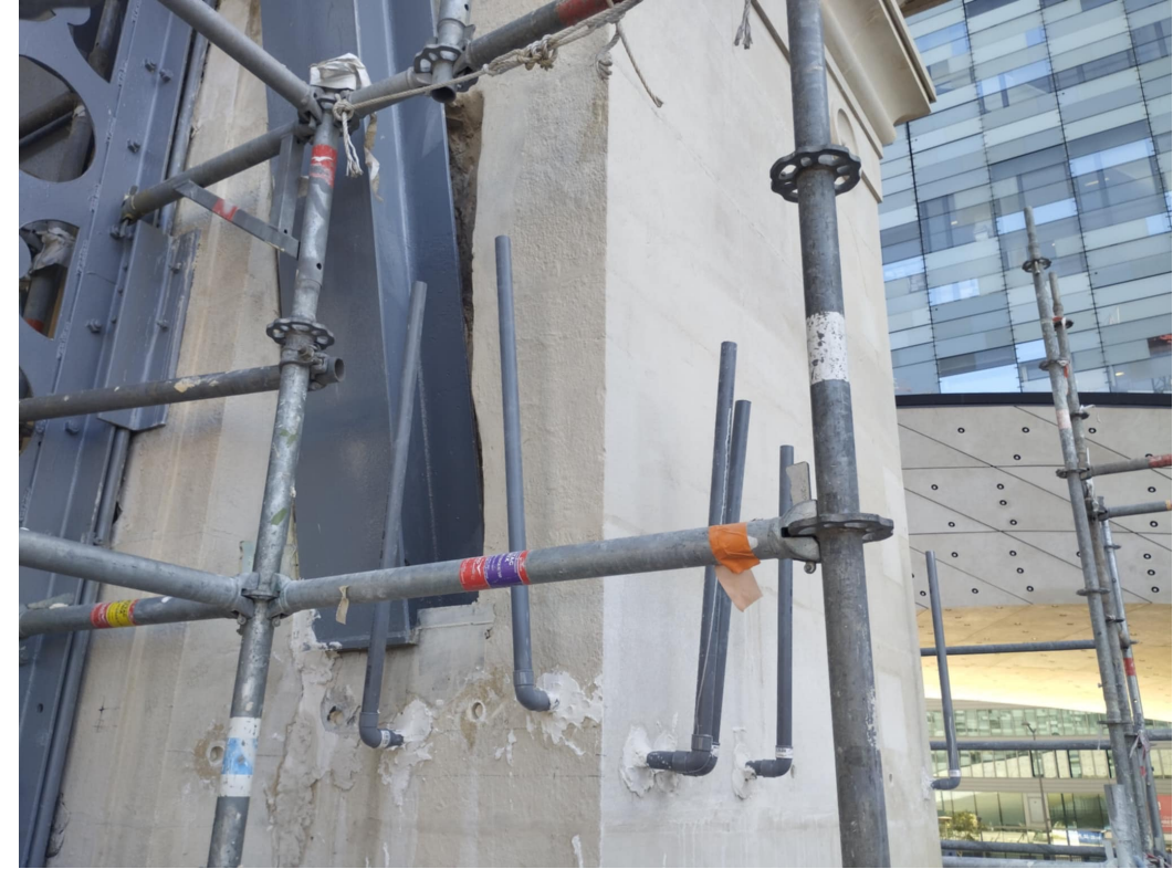
Exécution des scellements fibres / résine pour homogénéiser les assises : Sté Rénohors
