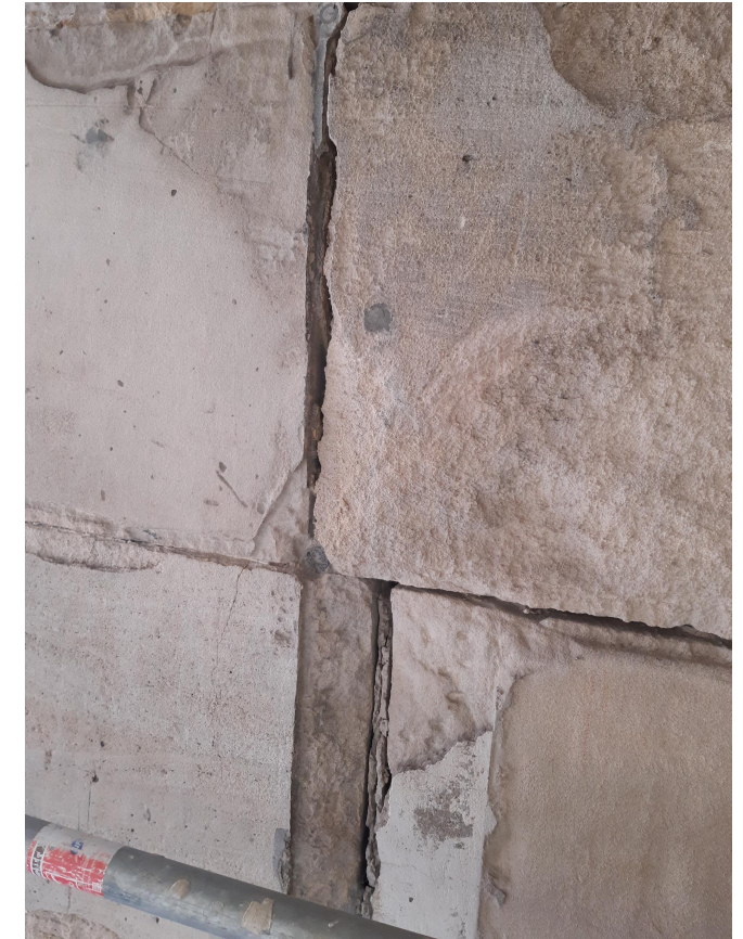
Dégradation des joints
