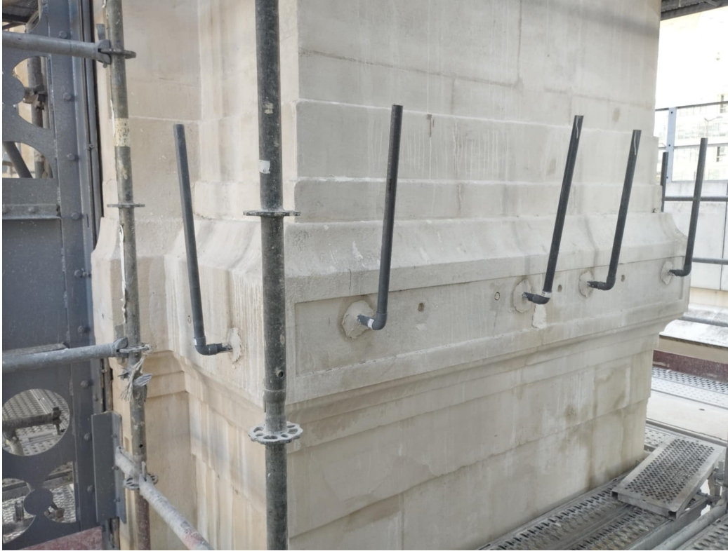
Exécution des scellements fibres / résine pour homogénéiser les assises : Sté Rénohors
