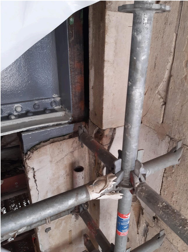
Dégradation de la pierre de placage
